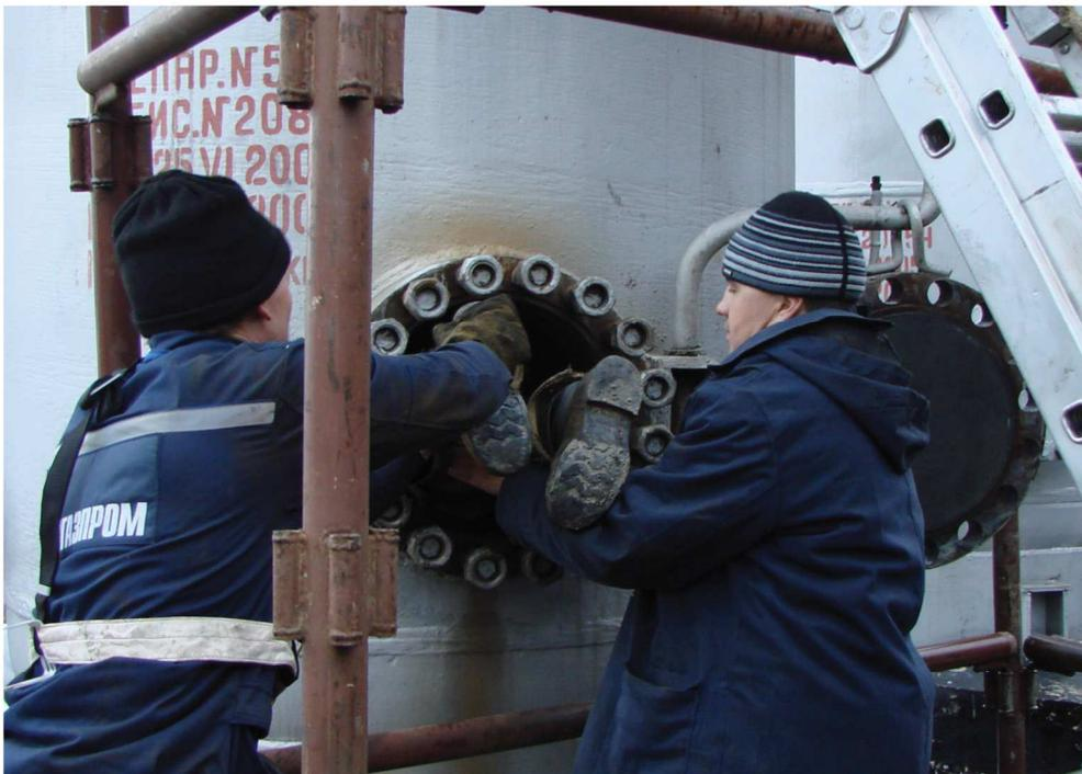
В ноябре 2009 года на УКПГ Мачехи была выполнена модернизация сепаратора 2 степени. Потребность в модернизации была вызвана неэффективной работой сепаратора, уносом жидкости с потоком газа. Данный метод был выбран по следующим причинам:
